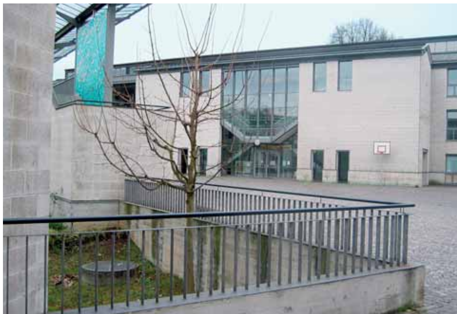
Es macht Sinn, die Brandschutzsituation in den Schulhäusern von Zeit zu Zeit von Fachleuten überprüfen zu lassen. (Bilder: Heinz Ammann)
