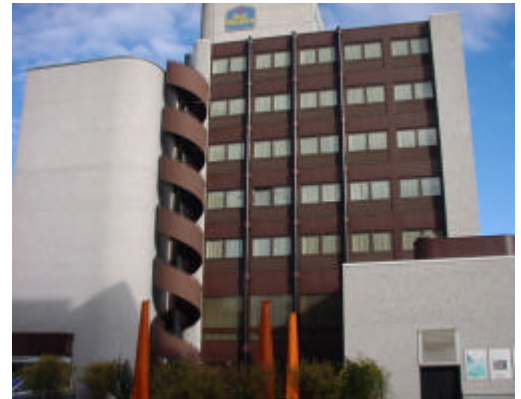
Die Fluchttreppe bei diesem Aarauer Hotel wurde nachträglich erstellt. Sie fügt sich gut in das Fassadenbild ein. Bilder: BSoft
