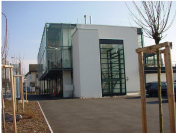
In der Doppelfassade ist die normale Erschliessung angeordnet. Rettungswege werden rückwärtig gelöst
